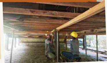
更换地面支撑
