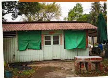
第239号房舍修复前
