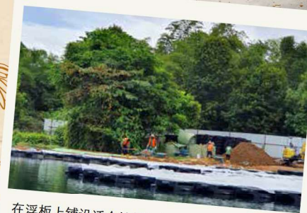
在浮板上铺设适合植物生长的泥土，用于设置新的漂浮湿地
