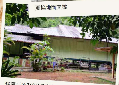
修复后的760D号房舍
