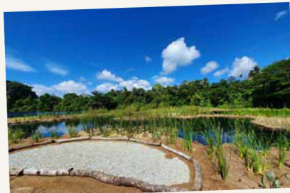
在新建成的漂浮湿地上，分散栽种植物，确保有足够空间供野生动物活动和栖息，也添置碎石与原木，打造自然生态。
